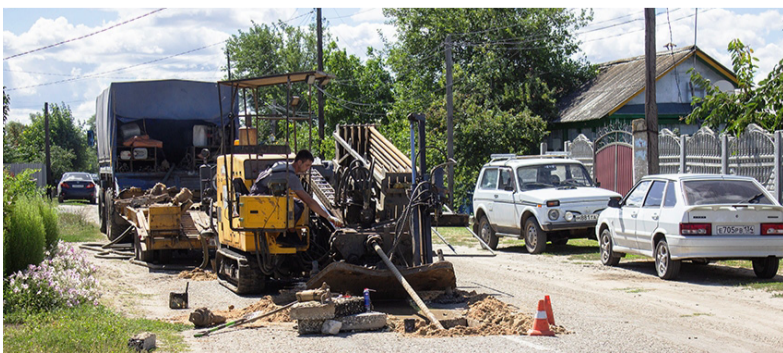
Ведутся работы по реконструкции алексеевского водопровода.
