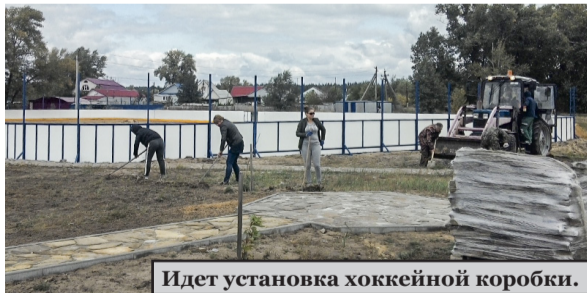
Идет установка хоккейной коробки.
